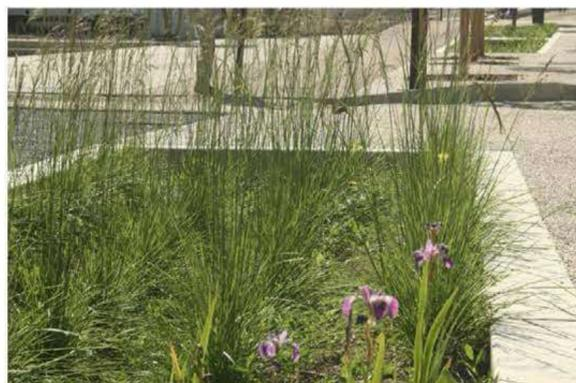
Principe d'optimisation des sols perméables et de mutualisation des fonctions : espaces d'usages permettant également la gestion des eaux pluviales.
